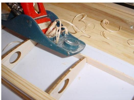
Raboter le haut du faux bord d'attaque pour suivre la pente donnée par la courbure des nervures.
