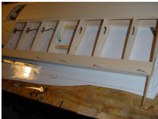
Coffrer le bord de fuite
